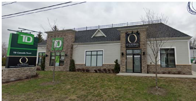
476-478, boulevard Adolphe-Chapleau (voisin de gauche/ Google Maps))
