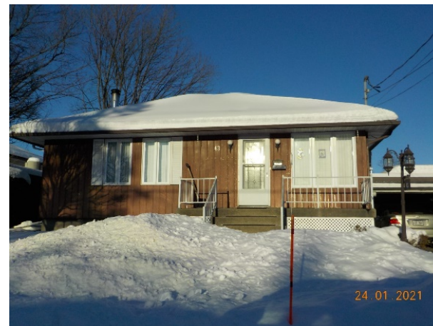
43, 32 e avenue (voisin de droite)
